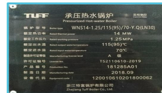
图 1 中心锅炉房热水锅炉铭牌
